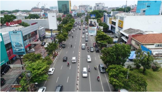
Gambar 3.4 Lokasi Evaluasi Pelayanan Fasilitas Penyeberangan Jalan Pejalan Kaki Jalan Pandanaran
