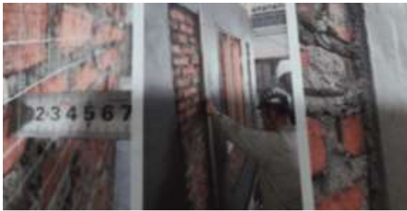
Gambar 16. Kawat Anyaman Berjarak 1 Meter dari Dinding Bata
