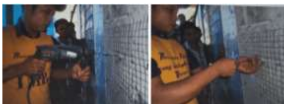
Gambar 19. Pengeboran Dinding untuk Menjahit Kawat Anyaman
